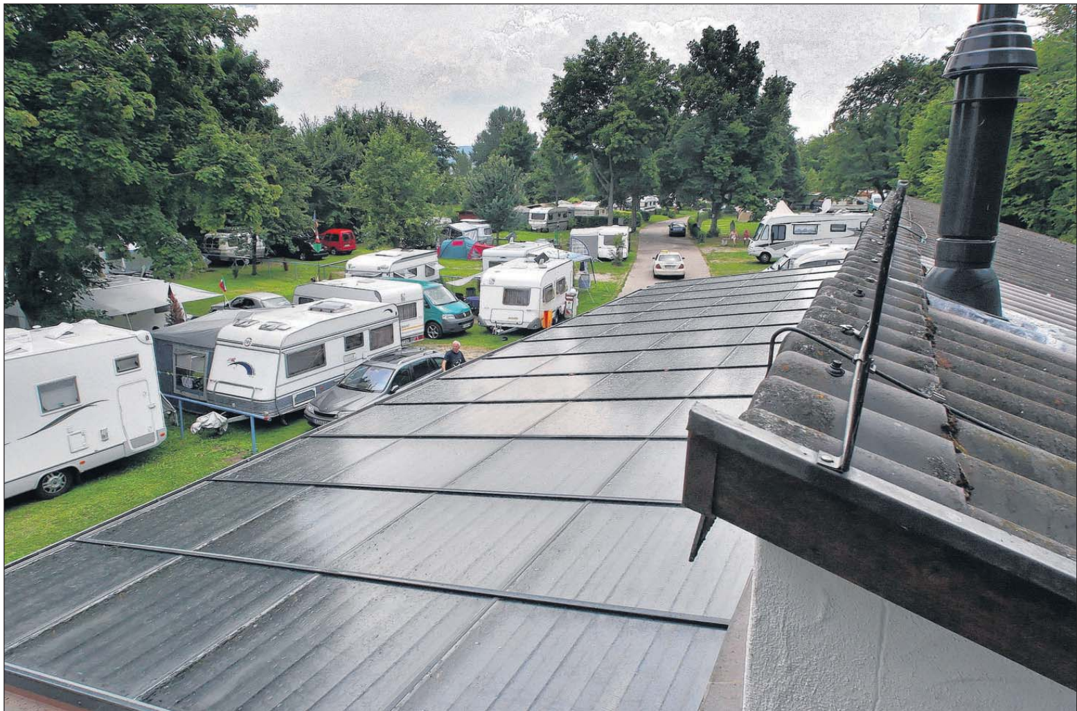
Der Tübinger Campingplatz hat seit März eine Solaranlage, die das Duschwasser erwärmt.
