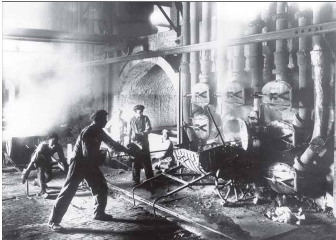
Blick in das 1908 gebaute alte Gaswerk an der Eisenhutstraße. Das Gas wurde aus Kohle gewonnen. Mit der anfallenden Abwärme wurde über eine Fernwärmeleitung das 1913 errichtete Umlandbad beheizt. Bild: Stadtarchiv
